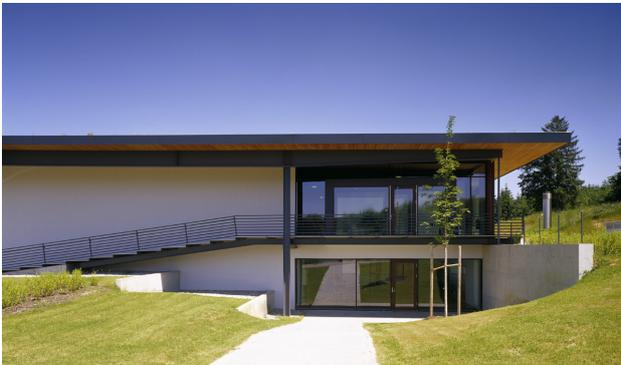
Das Dach ist über die gesamte Fläche extensiv begrünt. Die Gebäudeaussteifung erfolgt in der Längsrichtung durch Wandscheiben, in der Querrichtung bilden Binder und Stützen in Achse C einen biegesteifen Halbrahmen.
